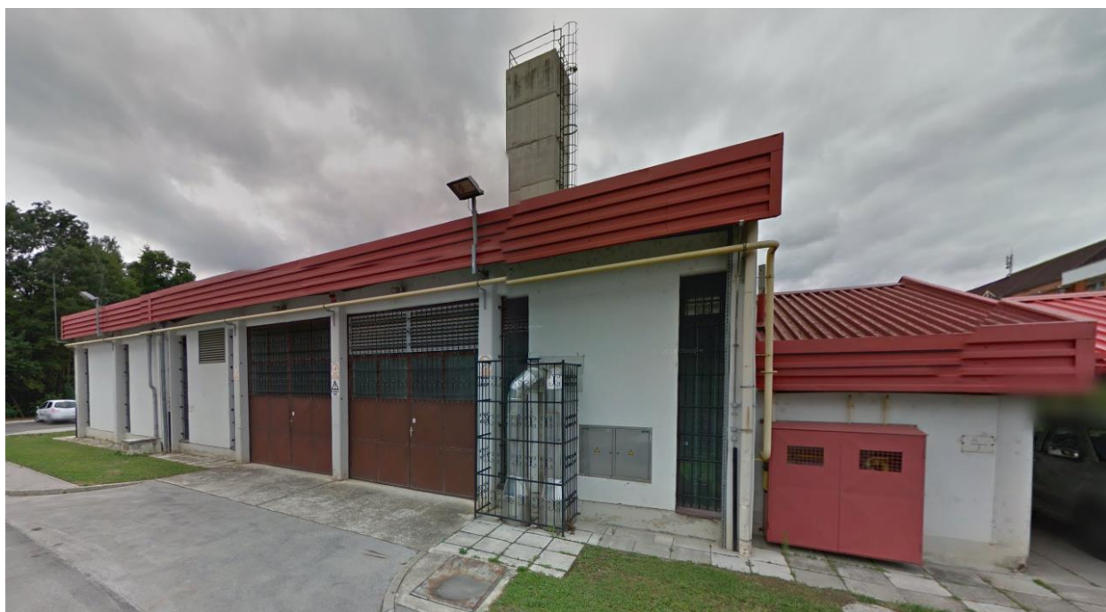
Slika 2: Centralna kotlovnica Dobrava
