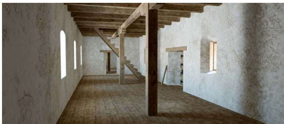
Pogled proti vzhodu v nadstropju starejšega dela grajskega palacija
