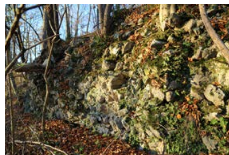
Ostanki nekdanje romanske južne stranice grajskega obodnega obzidja.
