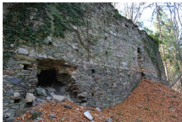
Značilna struktura zidave vzhodnega vogala in severovzhodne stranice obodnega obzidja. Vidne so novejšje poškodbe.
