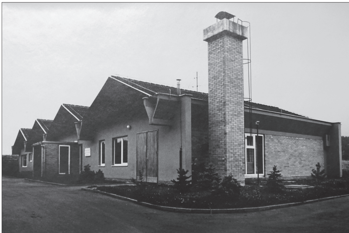
Stavba Osnovne šole na Stranica v sedemdesetih letih 20. stoletja (Vir: Šolska kronika Stranice, 1971–1983, št. 4)
