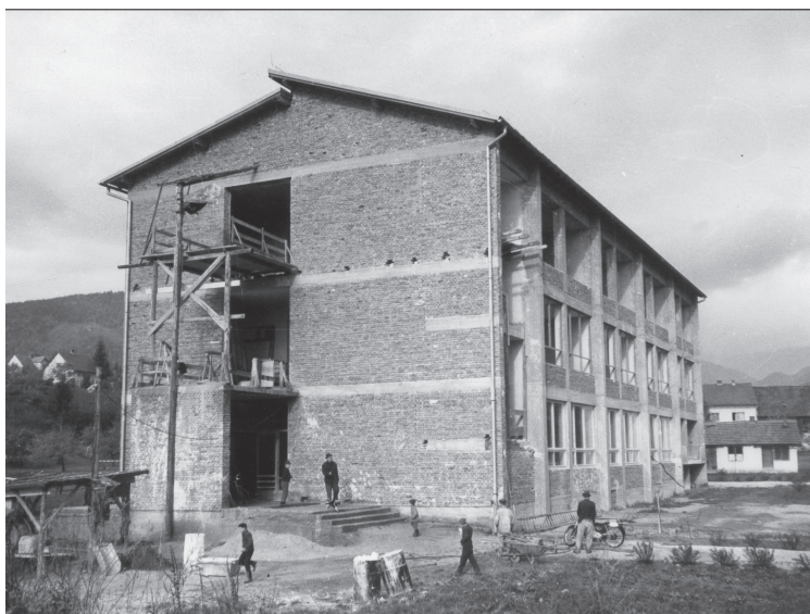
Šola v gradnji (Vir: Šolska kronika 1959/77)
