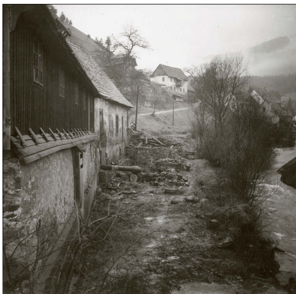
Sliki 6 in 7: Razdejan betonski vodni kanal ob kovačiji po povodnji, ki jo je povzročila narasla Bistrica februarja leta 1950, fotografiji iz osebnega arhiva Milka Bremca (vir: SI AS 1225 Milko Bremec (Melhior), 1890–1986, šk. 30).
