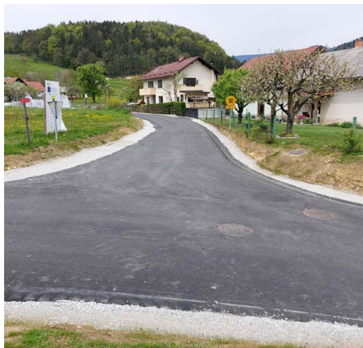
Zaključek del na kanalu S2 Vodovodna in Obvozna cesta
