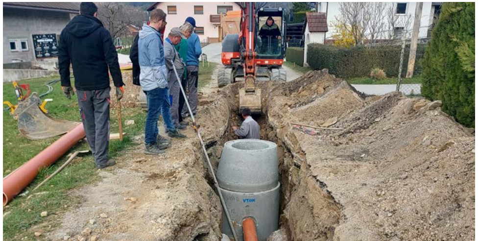
Izgradnja kanala S12 Rudniška cesta
