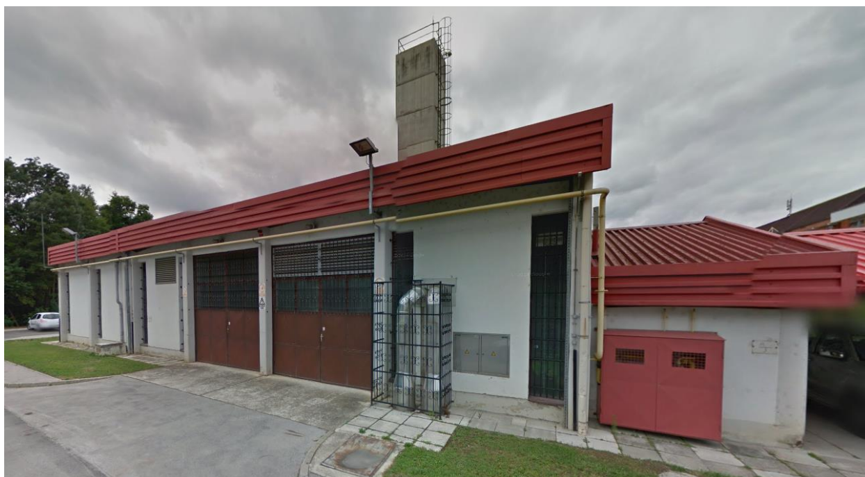
Slika 1: Centralna kotlovnica Dobrava
